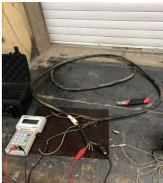
Рис. 3. Определение технического состояния изоляции кабеля
