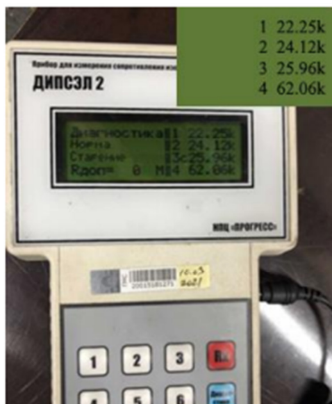
Рис. 6. Результаты замера сопротивления изоляции увлажненного кабеля
